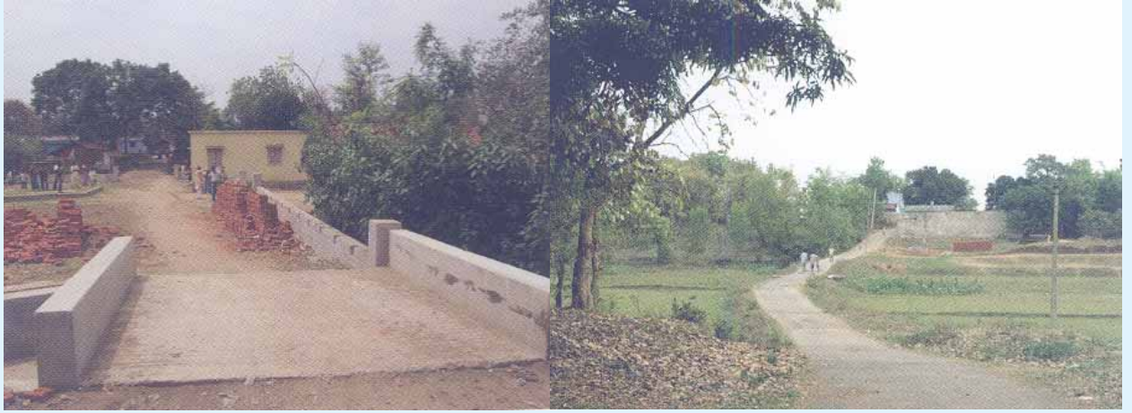
सेल के बोकारो इस्पात कारखाने द्वारा बांसगोरा में पुलिया का निर्माण (बाएं) तथा गांवों को सड़कों से जोड़ा जाना (दाएं)।
