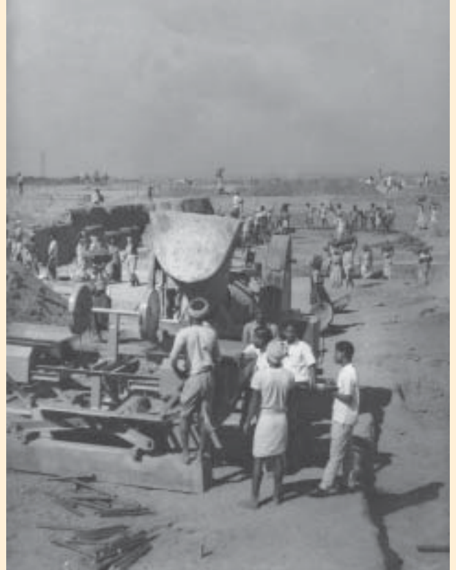
27 नवंबर, 1967: सेल के बोकारो स्टील प्लांट के लिए साइट समतलीकरण कार्य प्रगति पर।
