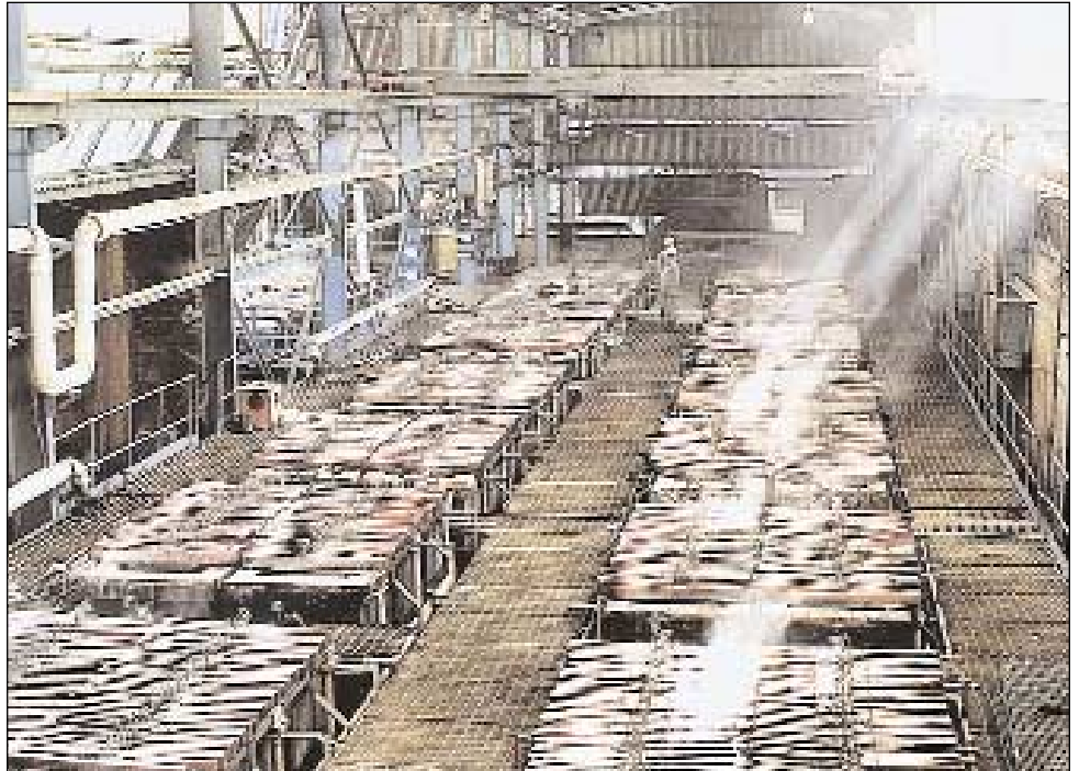
ईएमडी संयंत्र डोंगरी बुजुर्ग खदान का इलेक्ट्रोप्लेटिंग सेक्शन
